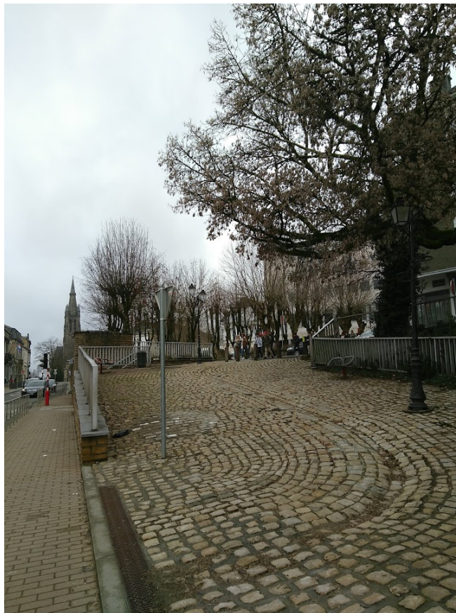
Photo 2 – rampe d'accès face à l'INDA
